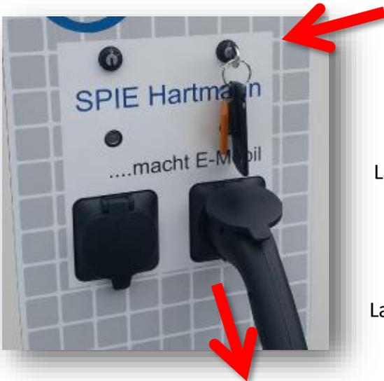
Schlüssel für die Ladesäule in das rechte Ladesäulenschloss stecken und den Schlüssel von **1** auf **0** drehen. Den Ladestecker nun aus der Ladesäule ziehen.
